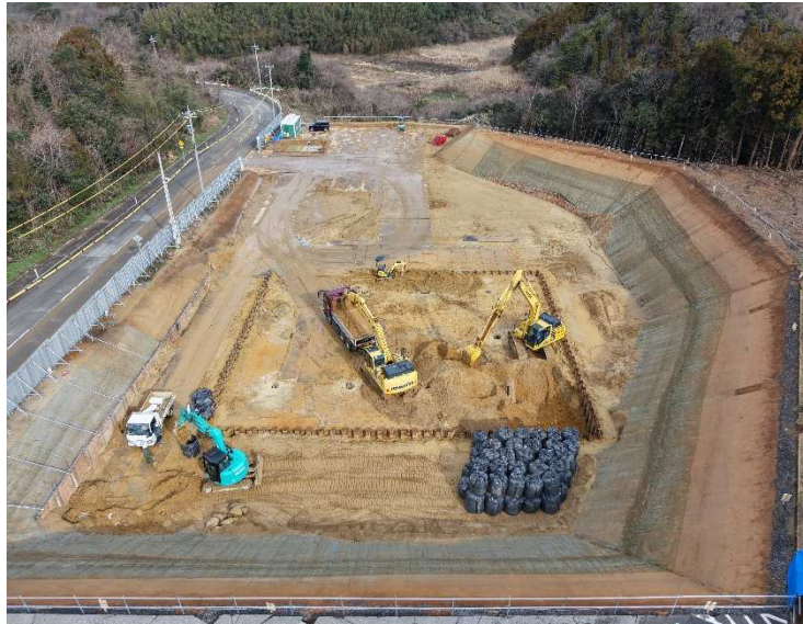
・建設地 北側（令和7年3月5日撮影）
