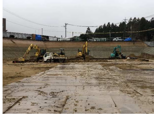
・建設地 南側（令和7年3月5日 撮影）
